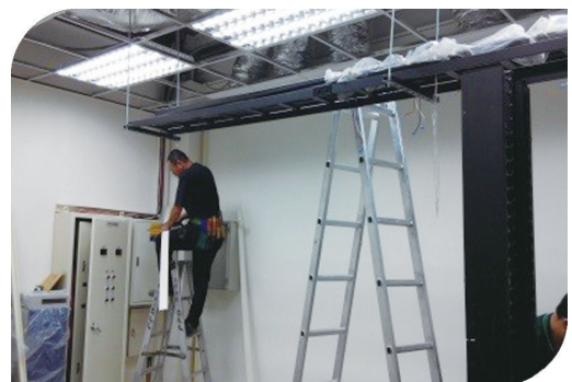
圖 2：電腦機房施工狀況
